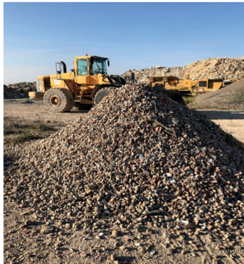
Ilustración 10 Acopio de la producción de suelo seleccionado.32-40.
