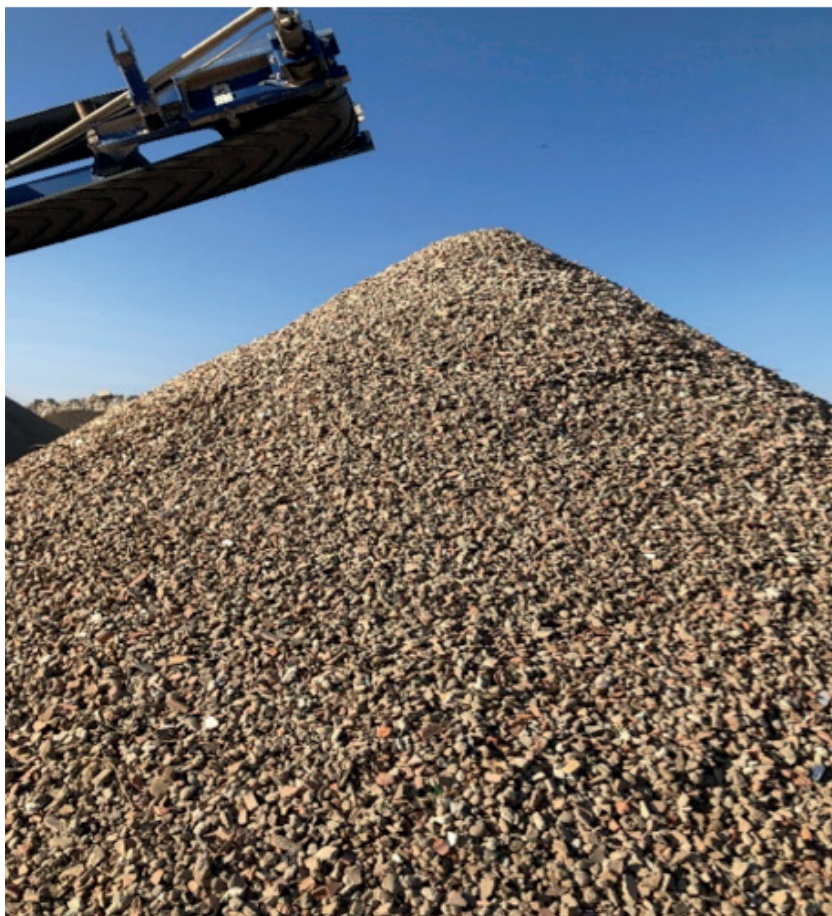
Ilustración 9 Acopio para elaboración arena reciclada 1° cribado. Procedente de Suelo seleccionado.
